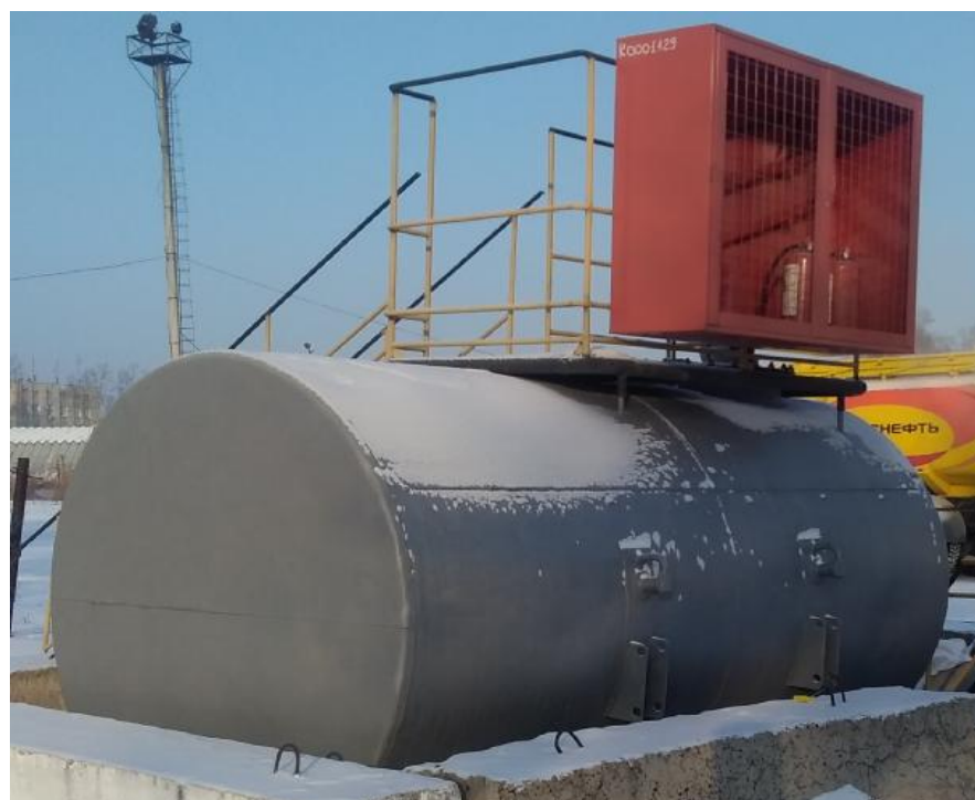
Рисунок 1 - Общий вид резервуара стального горизонтального цилиндрического РГС-6
